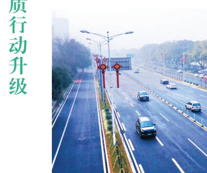
作为长沙“五纵五横”道路空间品质提升重点工程之一，湘江中路提质改造成“网红”路。范远志 摄
