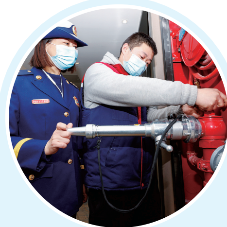
春节临近,宁夏银川市消防救援支队提前对大型商业综合体开展消防安全隐患排查检查。图为2月1日,消防监督检查人员在商务酒店内对消防栓压力进行测试。
