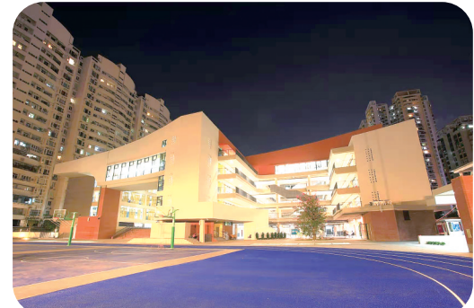
五矿二十三冶承建的石霞小学。
