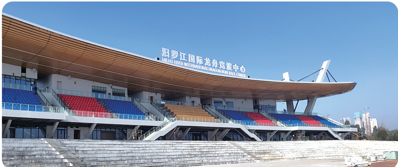
五矿二十三冶承建的汨罗江国际龙舟竞渡中心项目。
