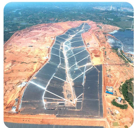
五矿二十三冶承建的宜昌石宝山磷石膏资源库项目。（本文图片由五矿二十三冶提供）
