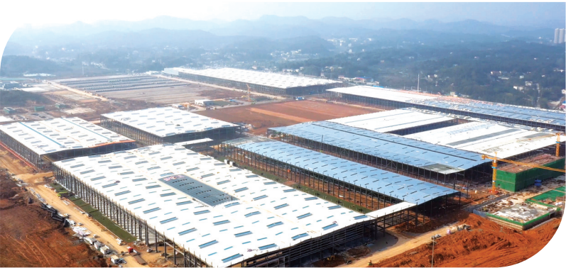
位于长沙高新区黄桥大道和枫林三路交会处东南角的中联智慧产业城项目,是一个投资千亿元的“巨无霸”建设项目。
