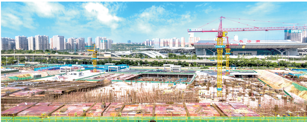
以高铁新城、雅塘、红星三大片区建设为抓手，雨花区开启加速跑。图为高铁新城片区黎托生态公园项目建设场景。
