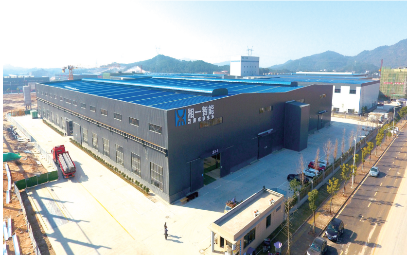
湘一智能建设基地内2号厂房正拔地而起。
