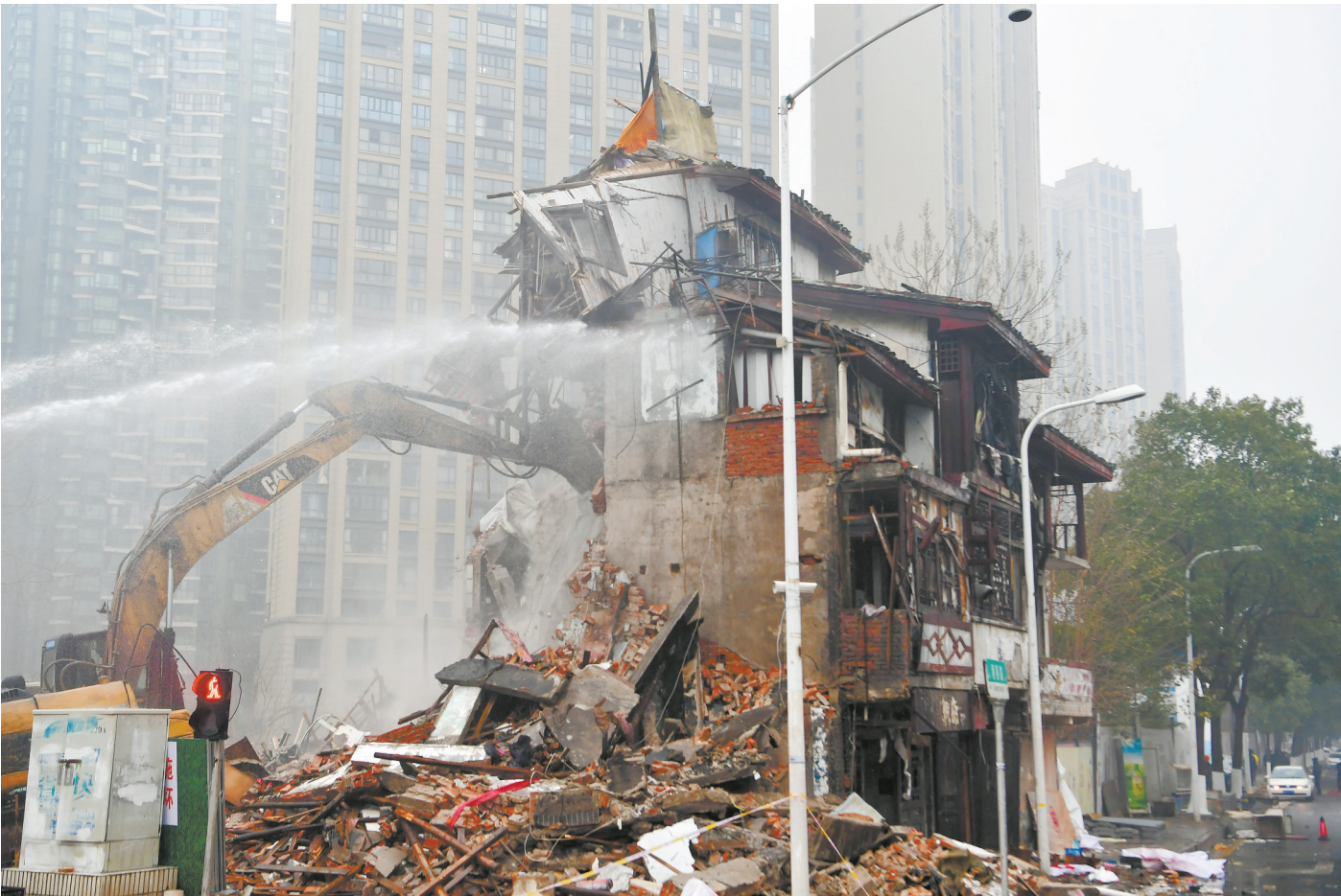
1月5日下午，工作人员操作挖掘机对“钉子房”进行拆除作业。
