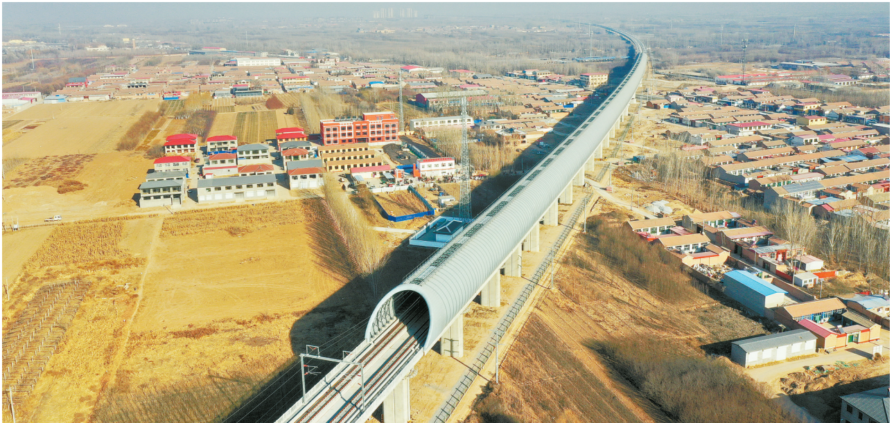
2020年12月27日，北京至雄安新区城际铁路大兴机场至雄安新区段开通运营，京雄城际铁路实现全线贯通，雄安站同步投入使用。图为京雄城际铁路河北霸州段的全封闭声屏障（2020年12月25日摄，无人机照片）。新华社发
