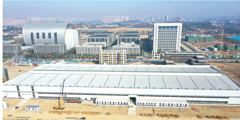
中富杭项目建设现场。
